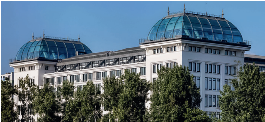
Bâtiment de l'OCDE à Boulogne.
