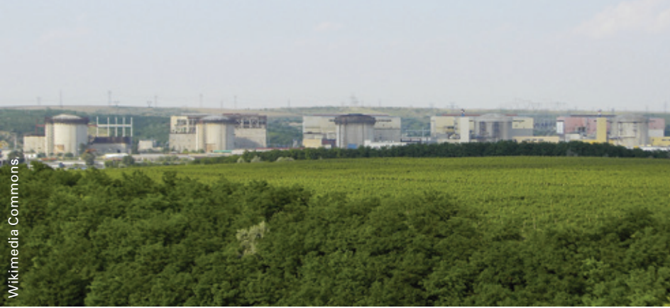
Centrale nucléaire de Cernavodă, Roumanie.
