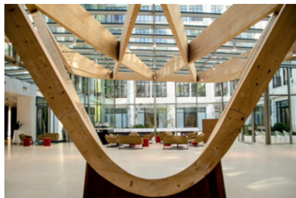
Bâtiment de l'OCDE à Boulogne.
