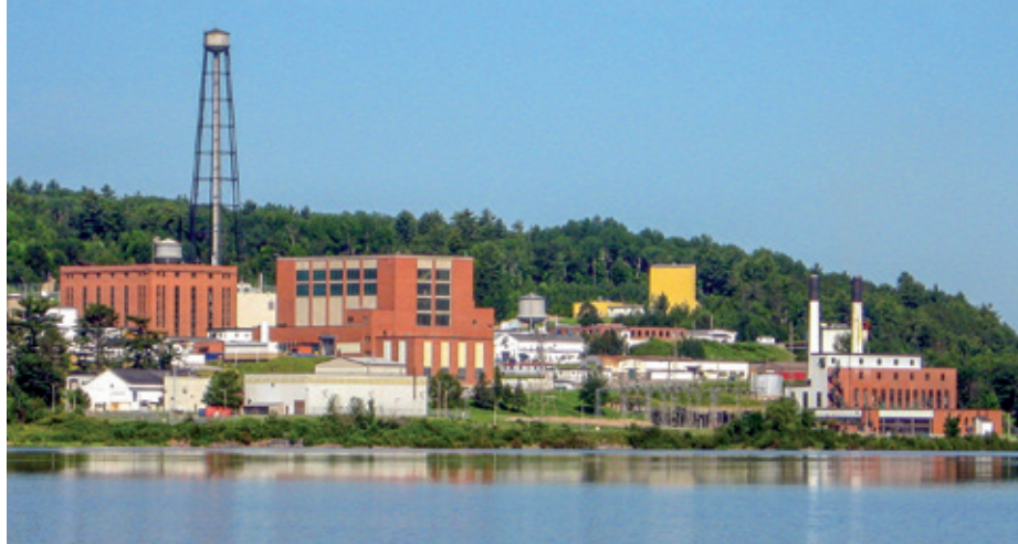
Le centre de stockage du combustible nucléaire usé d'Onkalo. Posiva, Finlande
