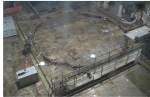
福島第一原子力発電所2号機原子炉建屋の上層階にあるオペレーティングフロア。放射性物質による汚染があるため遠隔操作の重機やロボットを用いて状況の確認などが行われている。写真提供:東京電力ホールディングス
