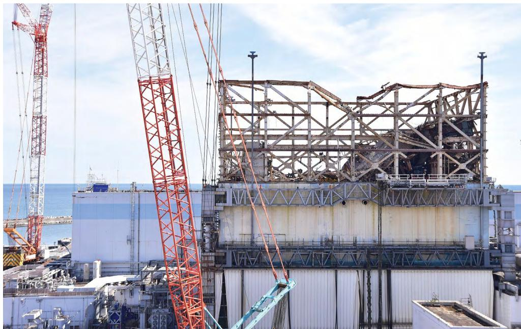
福島第一原子力発電所1号機原子炉建屋の近況（2021年3月撮影）。建屋を覆う大型カバーを設置しカバー内でガレキ撤去を行った後、2027年度から2028年度に使用済燃料プール内の燃料取り出し作業を開始する計画となっている。写真提供：東京電力ホールディングス
