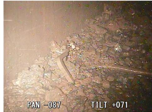
福島第一原子力発電所2号機原子炉建屋の内部、原子炉格納容器内にある燃料デブリ(原子炉内にあった燃料が事故で溶け、さまざまな構造物と混じりながら、冷えて固まった物質)の状態。調査装置先端に取り付けたカメラを遠隔操作によって操作し取得した映像。写真提供:東京電力ホールディングス
